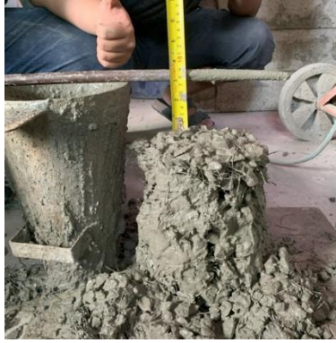
Gambar 13. Pengujian slump test
