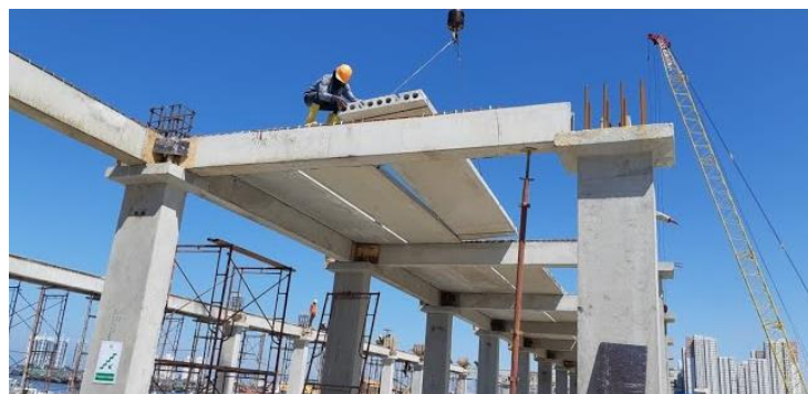
Gambar 2. 16 Sistem Beton Pracetak
