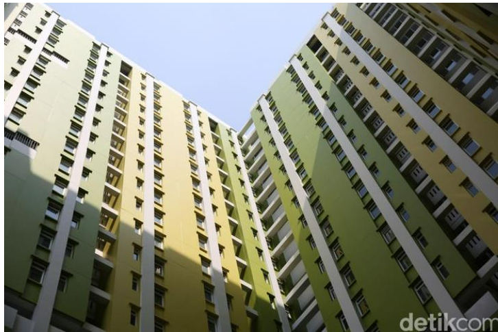
Gambar 2. 25 Rumah Susun Pasar Rumput Sumber : detik.com
