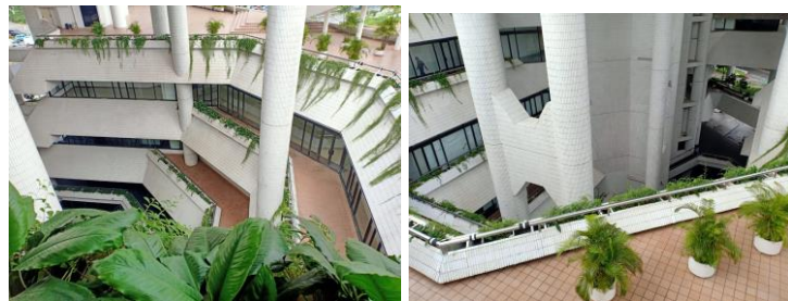
Gambar 2. 40 Balkon dan Void Sumber: Dokumentasi pribadi, 2023.
