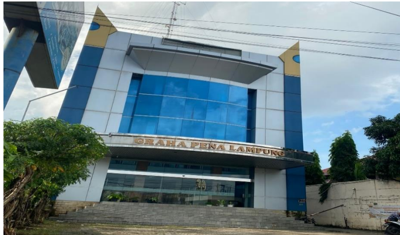
Gambar 1. Kantor Radar Lampung
