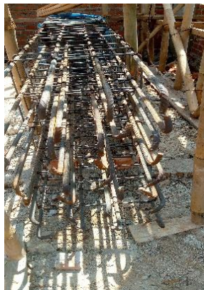
Gambar 3.2. Besi Beton Sumber: Dokumentasi Lapangan
