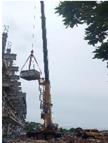
Gambar 3. 9 Crane Sumber : Dokumentasi Lapangan
