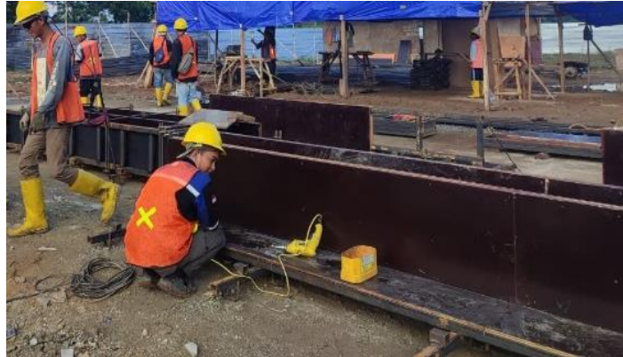
Gambar 3. 24 Moulding atau Bekisting Precast Sumber : Dokumentasi Lapangan
