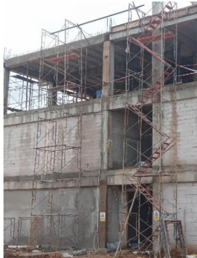
Gambar 3. 25 Tangga Scaffolding Sumber : Dokumentasi Lapangan
