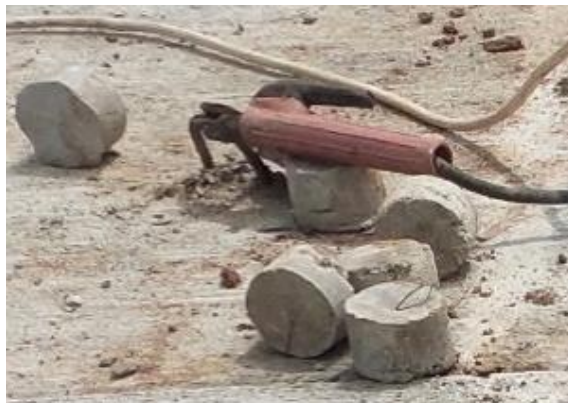
Gambar 3. 4 Beton Decking Sumber : Dokumentasi Lapangan
