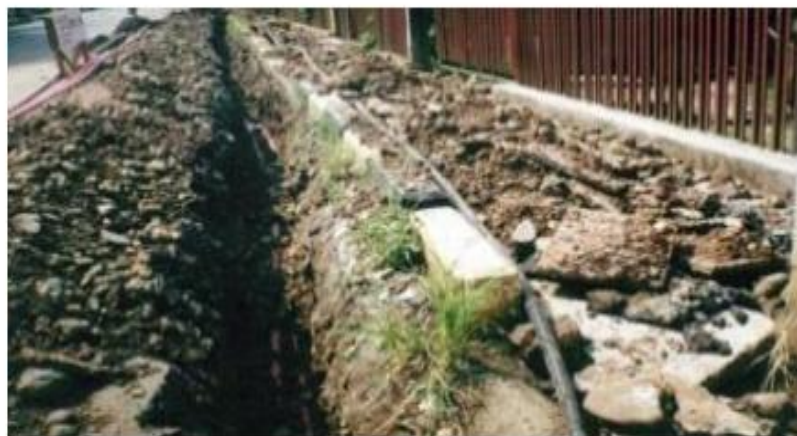
Gambar 3. Saluran Kabel Tanah Tegangan Menengah
