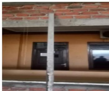
**Gambar 3.15 :** *Jidar alumunium*
