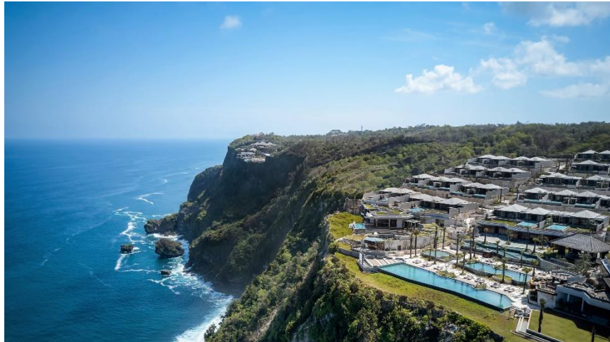
Gambar 2. 80 Bentuk Bangunan Six Senses Uluwatu Bali
