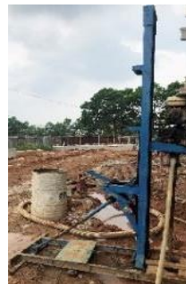
Gambar 3.22 Bor Tanah (Sumber : Dokumentasi Pribadi)
