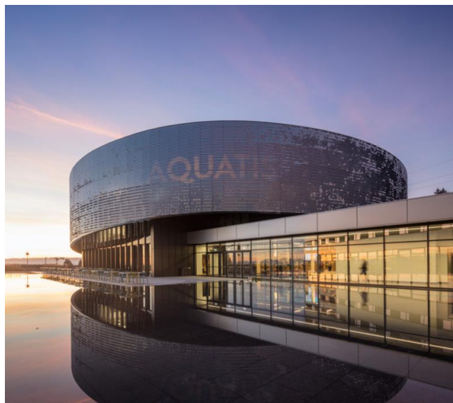
Gambar 2.25 Bangunan Akuarium dan pusat sains Lausanne (Sumber: Archdaily)
