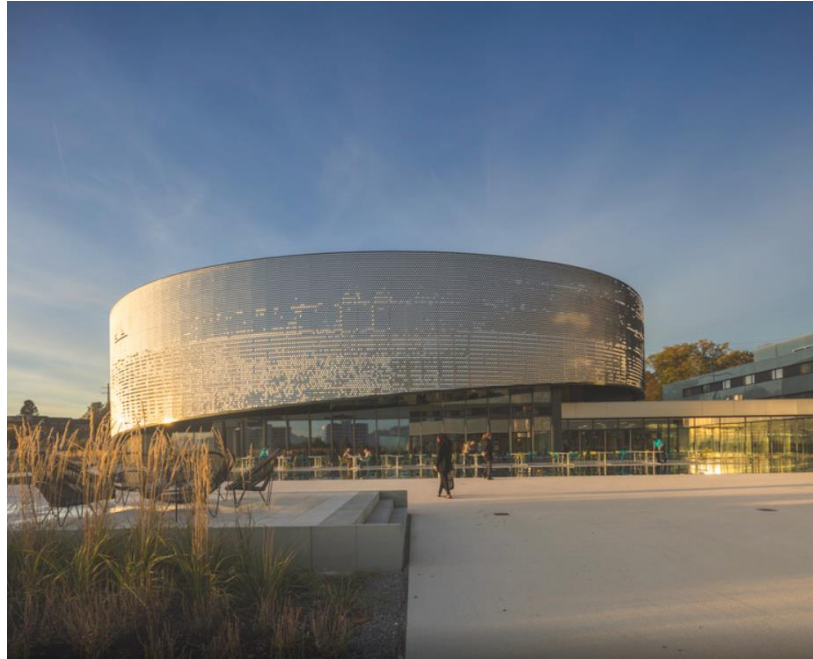
Gambar 2.22 Bangunan Aquarium dan pusat sains Lausanne (Sumber: Archdaily)
