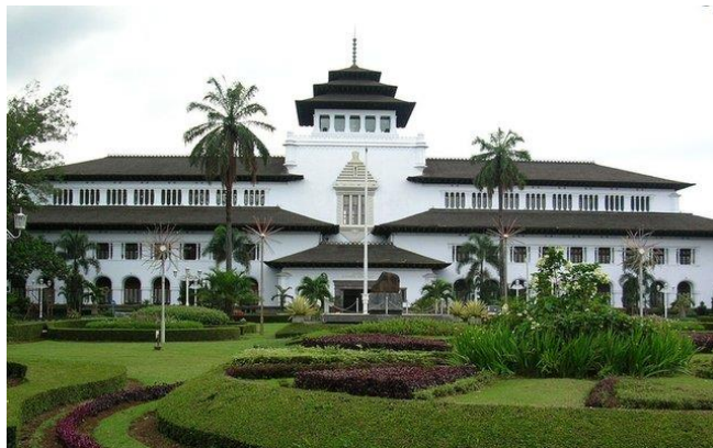
Gambar 2.8 Gedung Sate Bandung (Sumber: arsitag.com)
