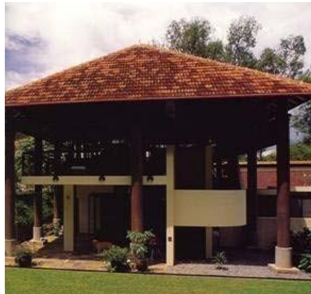
Gambar 2.34. Atap Reuter House berfungsi sebagai payung Sumber : Contemporary Vernacular Beng, 1998
