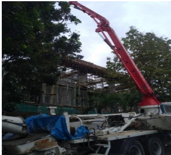
Gambar 3.9 Concret Pump Truck Sumber : Dokumentasi lapangan
