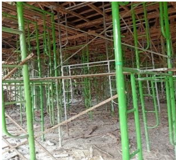
Gambar 3.16 Scaffolding Sumber : Dokumentasi lapangan
