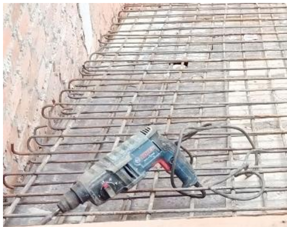
Gambar 3.15 Bor Sumber : Dokumentasi lapangan
