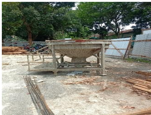
Gambar 3.18 Concrete Bucket Sumber : Dokumentasi lapangan
