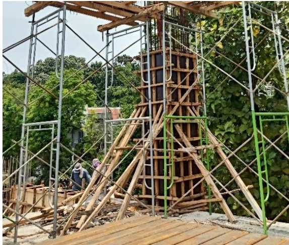
Gambar 3.19 Bekisting Sumber : Dokumentasi lapangan
