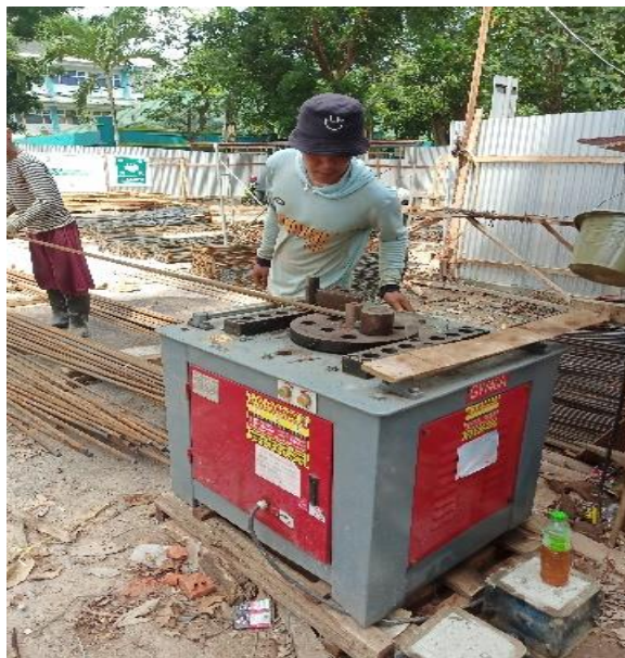
Gambar 3.11 Bar Bender Sumber : Dokumentasi lapangan
