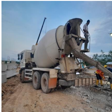
Gambar 3.1. Beton Ready Mix Sumber : Dokumentasi Lapangan
