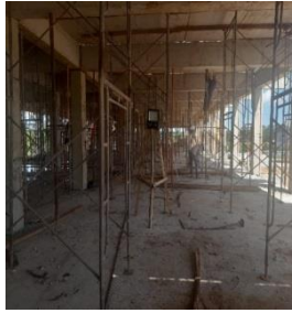
Gambar 3.20. Scaffolding (Perancah) Sumber : Dokumentasi Lapangan
