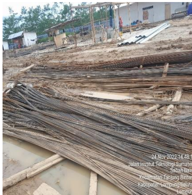
Gambar 3.2. Besi Tulangan Sumber : Dokumentasi Lapangan
