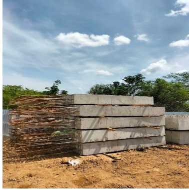
Gambar 3.6. Kolom Precast Sumber : Dokumentasi Lapangan
