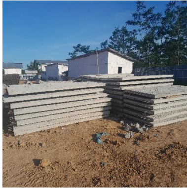
Gambar 3.8. Plat lantai Precast Sumber : Dokumentasi Lapangan
