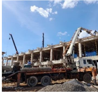
Gambar 3.36. Concrete Pump Sumber : Dokumentasi Lapangan
