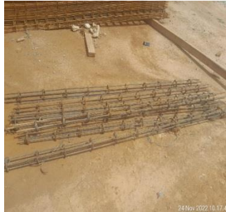
Gambar 3.9. Kolom Praktis Precast Sumber : Dokumentasi Lapangan
