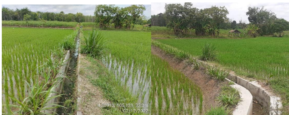
Gambar 17. Dokumentasi Saluran Primer DI Way Tulung Buho Sumber: Hasil Survey Lapangan, 2022
