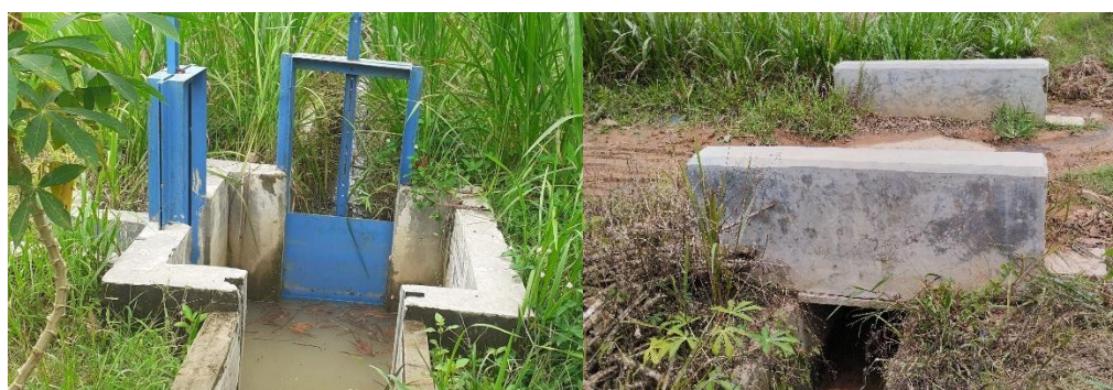
Gambar 18. Dokumentasi Bangunan Pelengkap DI Way Tulung Buho Sumber: Hasil Survey Lapangan, 2022
