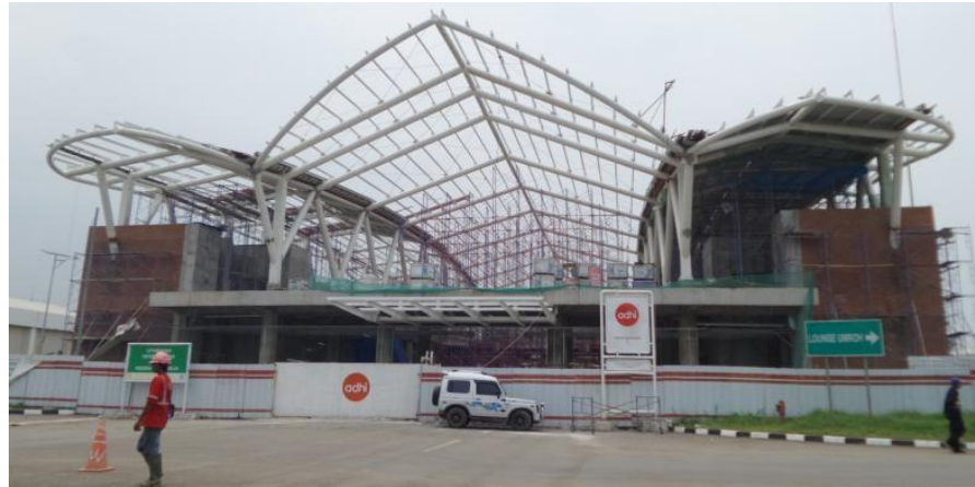
Gambar 2.29. Struktur Bangunan Stasiun Kereta Api Bandara Soekarno Hatta
