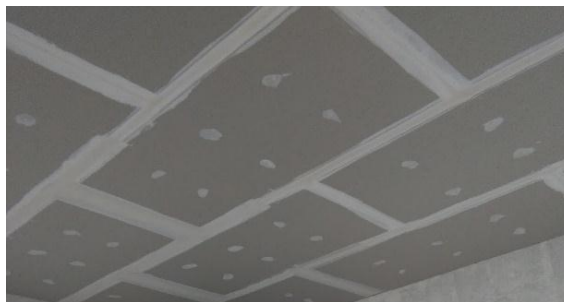
Gambar 3.24 Gypsum Sumber : Foto Lapangan
