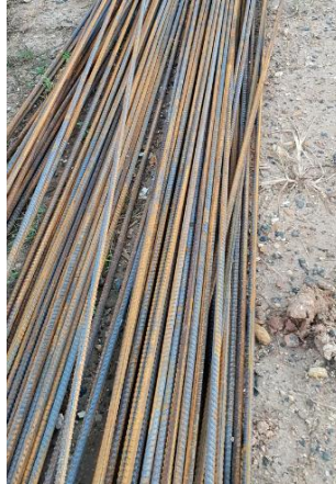
Gambar 3.22 Besi Tulangan 10mm
