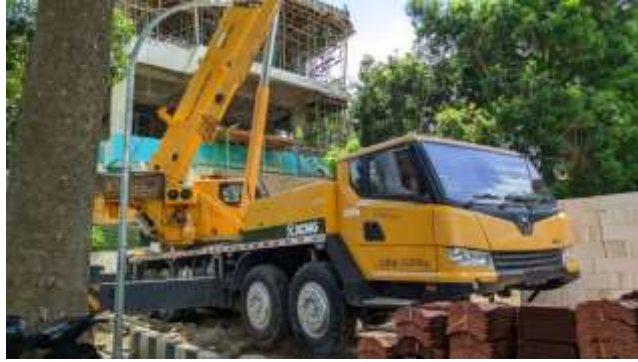
Gambar 3.14 Truck Crane Sumber: Dokumentasi Lapangan
