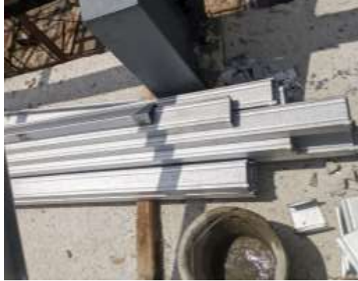
Gambar 3.4 Baja Ringan C75 Sumber : Dokumentasi Lapangan
