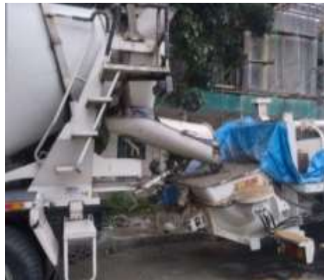
Gambar 3.13 Concrete Pump Sumber: Dokumentasi Lapangan
