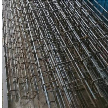
Gambar 3. 20 Besi Tulangan Sumber : Foto Lapangan
