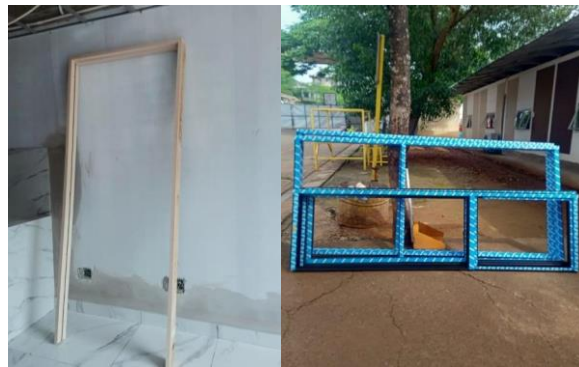
Gambar 3. 13 Kusen pintu dan jendela (Sumber : Dokumentasi Penulis, 2022)
