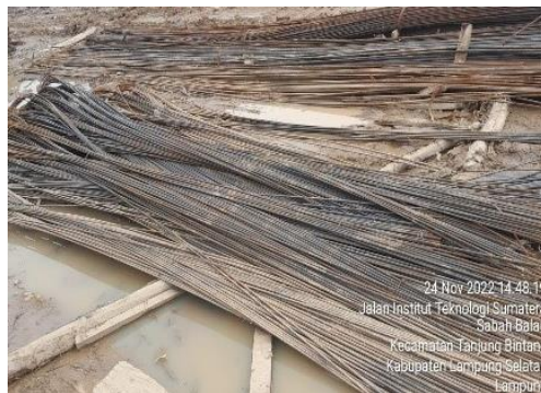
Gambar 3.7 Besi Tulangan (Sumber : Dokumentasi Penulis, 2022)
