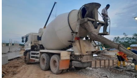
Gambar 3.6 Beton Ready Mix (Sumber : Dokumentasi Penulis, 2022)
