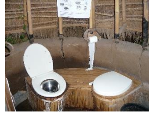
Gambar 2.22 Dinding Tanah Liat
