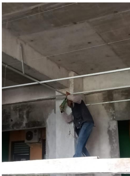
Gambar 4.19 : Pemasangan rangka tepi dengan paku beton Sumber : Foto Lapangan
