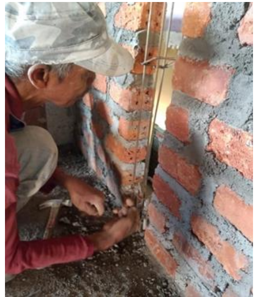
Pemasangan kolom praktis
