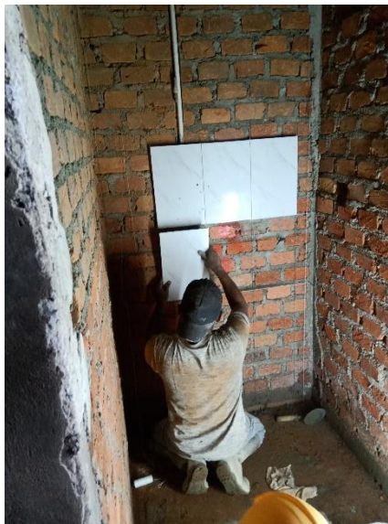
Gambar 4.15 : Meletakkan keramik pada dinding Sumber : Foto Lapangan
