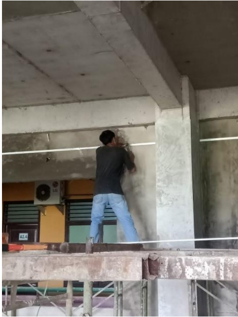
Pemasangan rangka tepi pelafond
