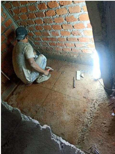
Pemasangan benang acuan
