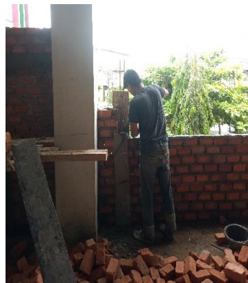
Gambar 4.5 : Pengecoran kolom praktis mengikuti ketinggian pemasangan batu bata Sumber : foto lapangan
