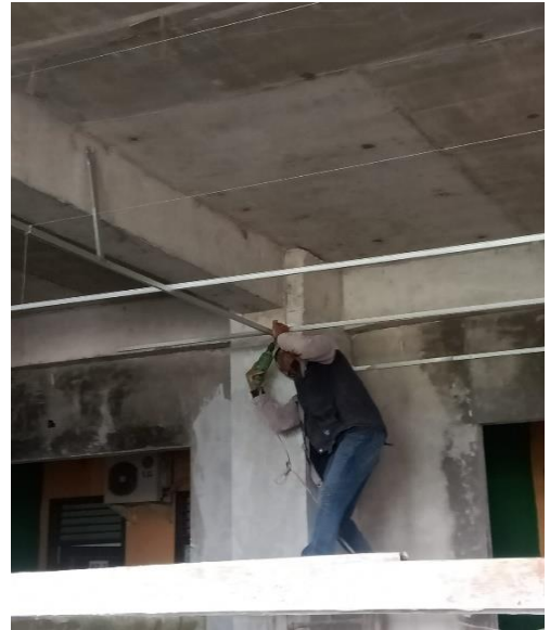
Pemasangan rangka hollow tpelafond
