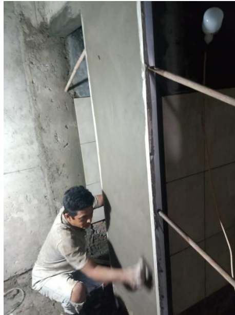
Gambar 4.11 : Pekerjaan acian menggunakan spons Sumber : foto lapangan
