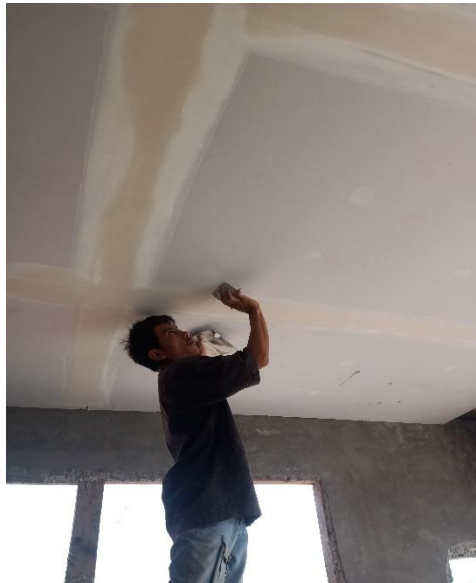
Gambar 4.22 : Penutupan sambungan plafond dengan kain kasa gypsum dan compound putih Sumber : Foto Lapangan
