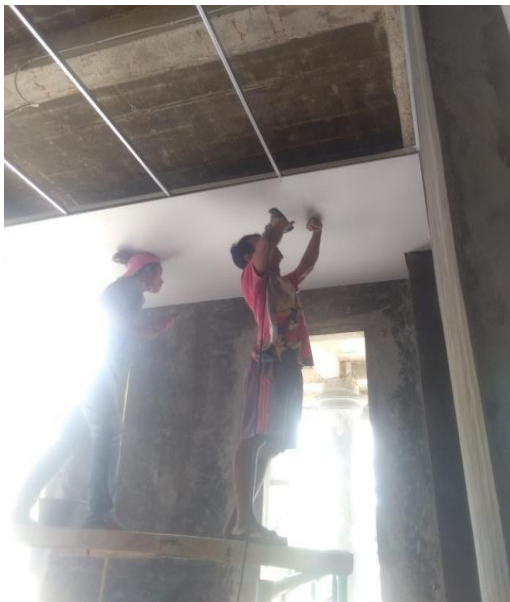
Pemasangan pllfond gypsum
