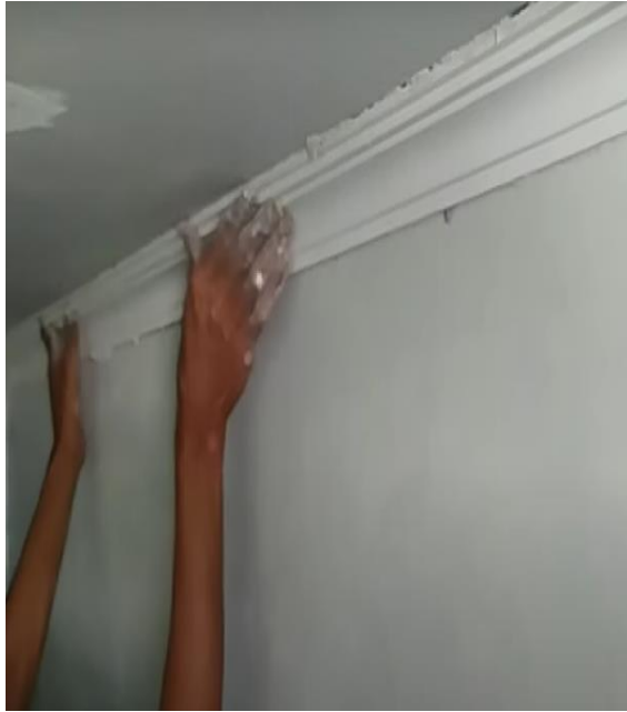
Pemasangan lis plafond
