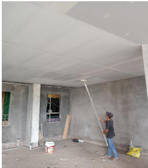
Gambar 4.24 : Pengecatan plafond menggunakan roller
