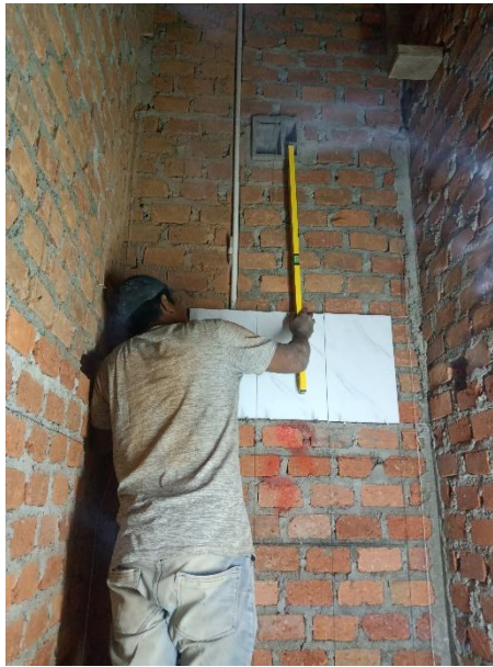
Gambar 4.17 : Pengecekan kelurusan keramiik menggunakan waterpass
