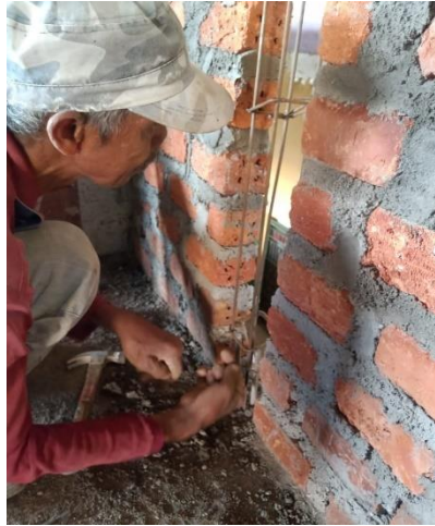
Gambar 4.2 Pemasangan kolom praktis
