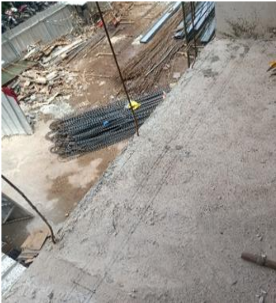
Marking pada lantai kerja
