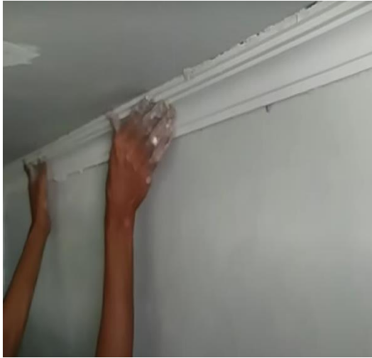
Gambar 4.23 : Pemasangan lis plafond
