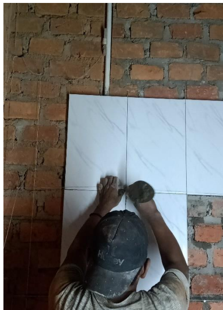
Gambar 4.18 : Pemasangan fisher pada nat keramik
