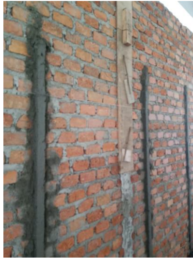
Gambar 4.8 : Peletakan caplakan/kepalan plester Sumber : foto lapangan
