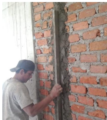
Gambar 4.7 : Pembuatan caplakan/kepalan plester
