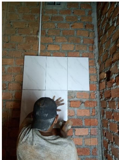
Gambar 4.16 : Pengetukan dinding keramik menggunakan palu karet Sumber : Foto Lapangan
