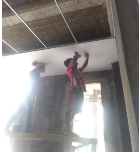
Gambar 4.21 : Pemasangan plafond gypsum Sumber : Foto Lapa
