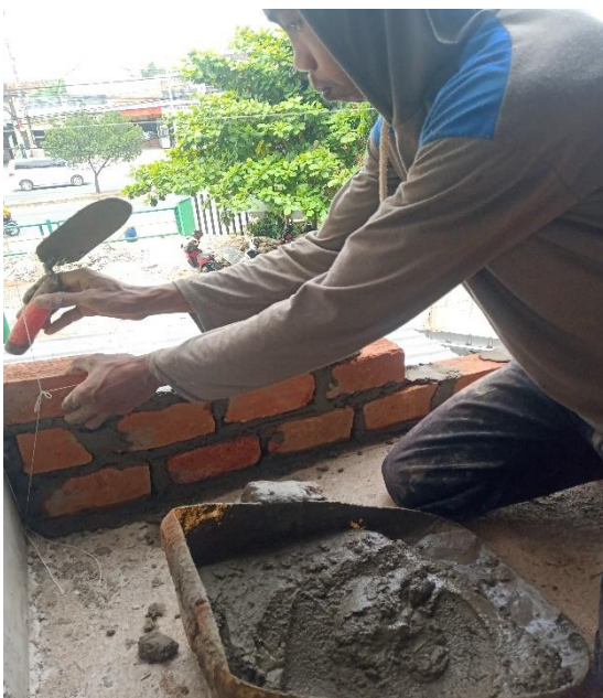
Pemasangan batu bata
