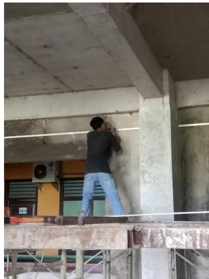
Gambar 4.19 : Pemasangan rangka tepi dengan paku beton Sumber : Foto Lapangan
