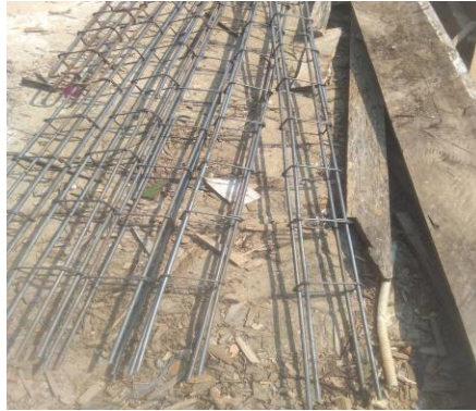
Gambar 3.22 : Besi Tulangan 10mm Sumber : Foto Lapangan
