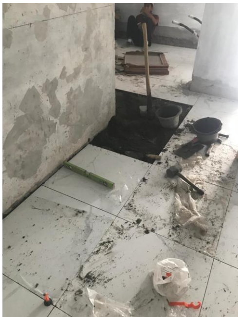
Pekerjaan keramik lantai
