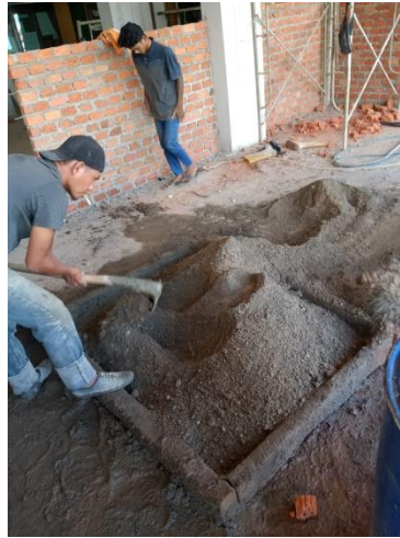
Gambar 4.6 Pengadukan mortar
