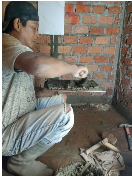
Gambar 4.14 : Meletakkan adukan ke bagian keramik Sumber : Foto Lapangan
