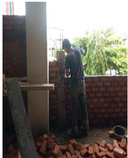
Pengecoran kolom praktis
