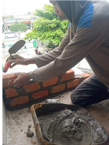
Gambar 4.4 Pemasangan batu bata dengan cara di ketuk Sumber : foto lapangan
