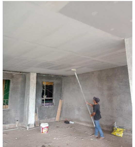
Pengecatan plafond menggunakan roller
