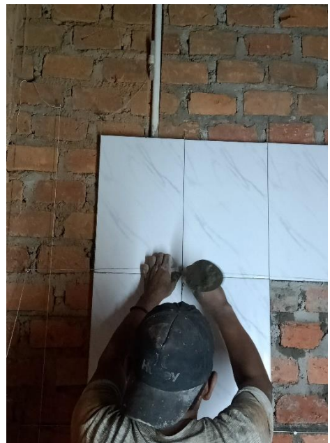
Pemasangan fisher pada nat keramik
