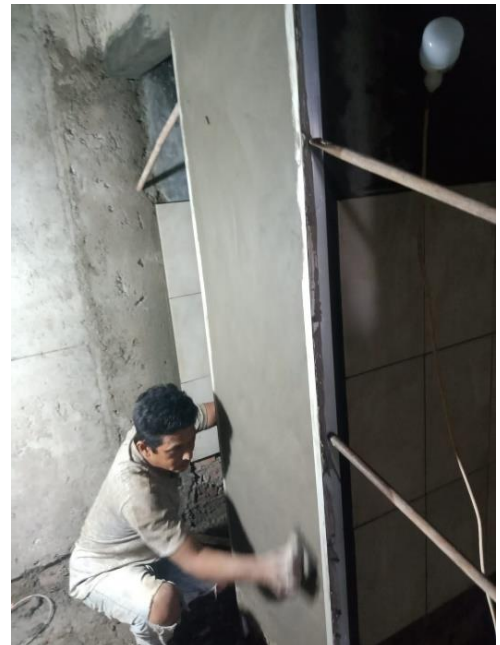
N Pekerjaan acian
