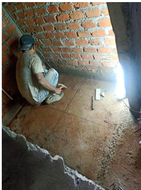
Gambar 4.13 : Proses Pemasangan benang acuan pada dinding
