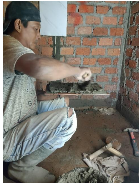
Peletakan adukan semen di bagian keramik
