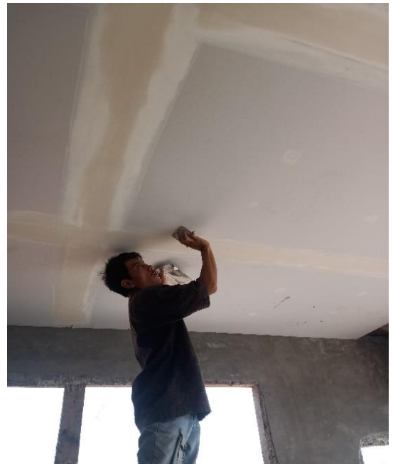
Penutupan sambungan plafond dengan kasin kasa dan compund
