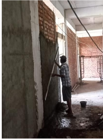
Gambar 4.10 : Perataan plesteran menggunakan jidar Sumber : foto lapangan
