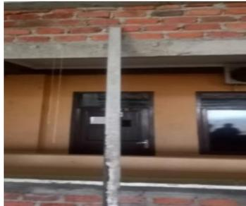
**Gambar 3.16 :** *Jidar alumunium*
