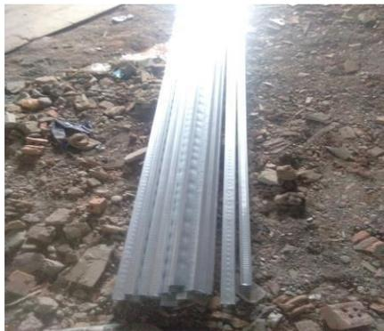
**Gambar 3.23 : Hollow alumunium**
