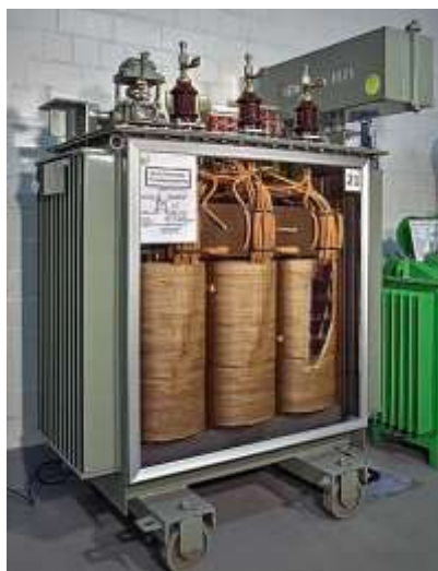
Gambar 2. 3 Isolasi kertas pada transformator[10]
