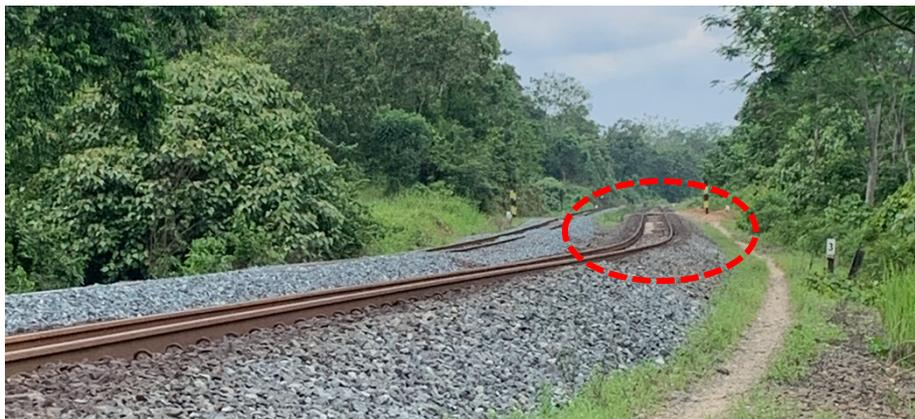
Gambar 1.4 *Mud pumping* dan deformasi pada *track*
