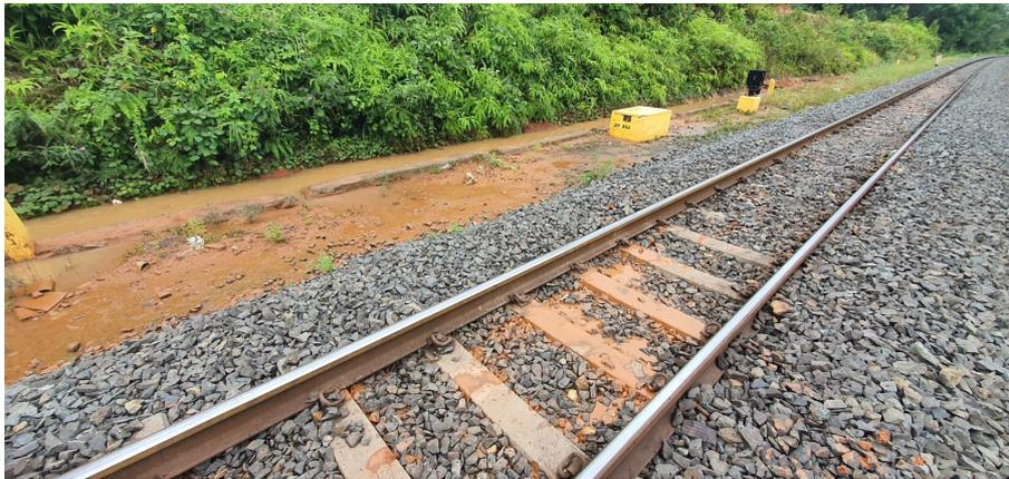
Gambar 1.3 Sistem drainase yang buruk pada *track*
