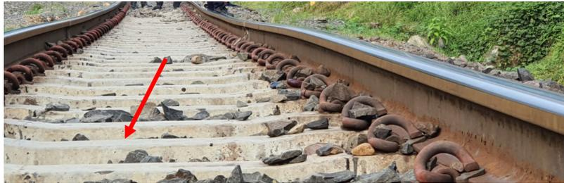
Gambar 2.4 Bantalan pada struktur jalan rel
