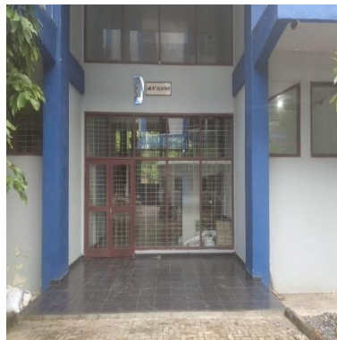
Gambar 3.3. Laboratorium inti jalan raya.
