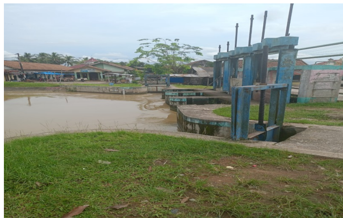
Gambar 4.2 Bendungan Komering BK 11.
