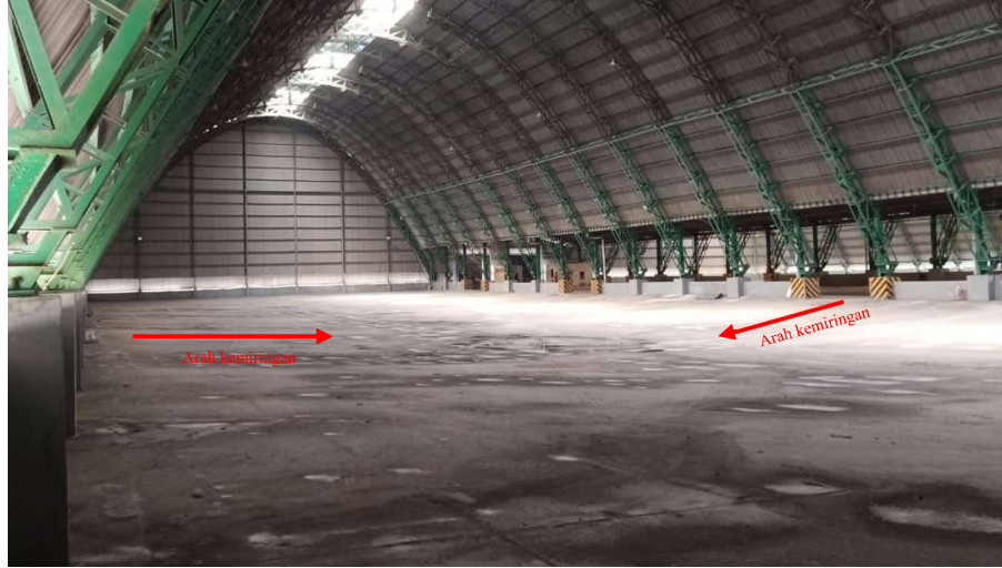
Gambar 2. Kondisi Penurunan Tanah Gudang Segmen A (Sumber: Survei Penelitian, 2023)
