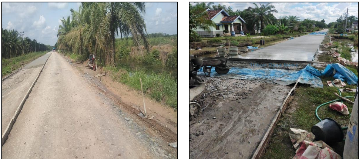
Gambar 4.4 Jalan Desa Wonosari dan pembangunan jalan desa wonosari
