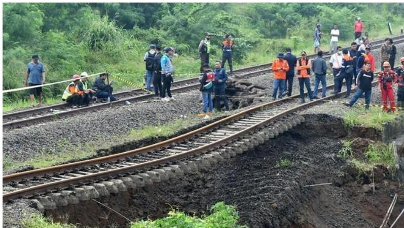
**Gambar 2. 1** Tanah Longsor Pada Jalur Kereta Api
