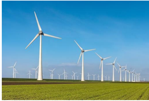
Gambar 7. Pembangkit listrik tenaga angin.
