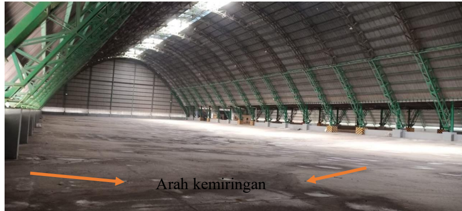
Gambar 3. Arah Kemiringan Lantai Pada Segmen Kanan dan Kiri Gudang Biru Bagian A.
