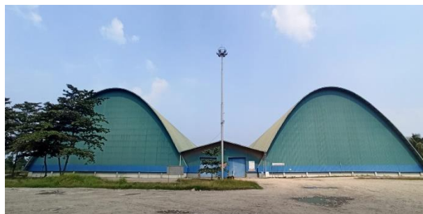
Gambar 16. Tampak Depan Gudang Biru PT Pelabuhan Indonesia (Persero). (Sumber: Survey Penelitian , 2023)
