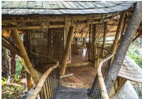
**Gambar 2.26.** Penggunaan bambu pada dinding bangunan
