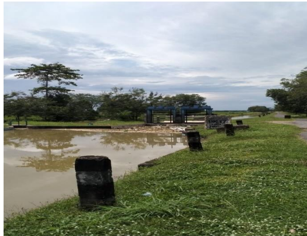
Gambar 7. Aliran bendungan komering
