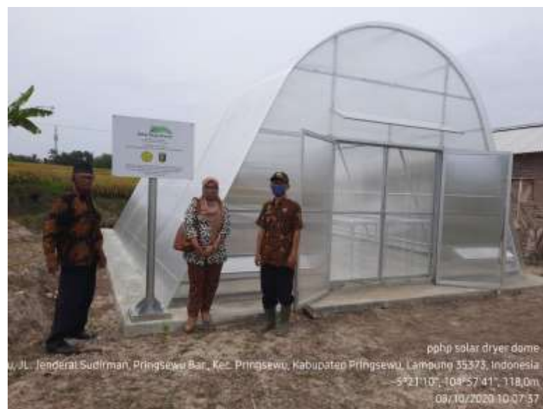
Gambar 4. Bangunan solar dryer dome di Kabupaten Pringsewu
