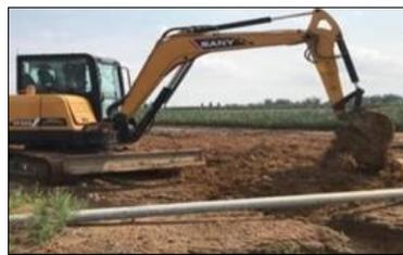
Gambar 9. *Excavator* untuk pembuatan jalan dan drainase.
