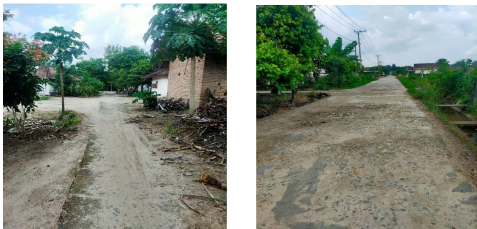
Gambar 4.2 Infrastruktur Jalan Desa Gantiwarno
