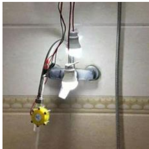
Gambar 1. Pembangkit Listrik Tenaga Air Mikro
