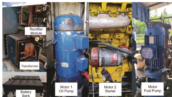
Gambar 3. 2 Konfigurasi Sistem Rectifier pada PLTG UPK Sebalang
