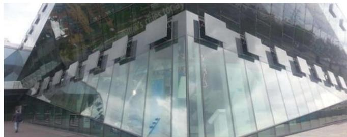
Gambar 2 78 Ventilasi alami pada bangunan The Crystal
