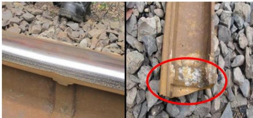
Gambar 11. Patah Pada Sambungan.
