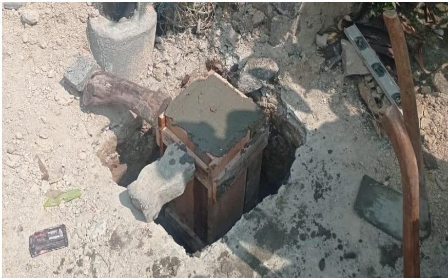
Gambar 17. Pemasangan benchmark titik pengamatan.
