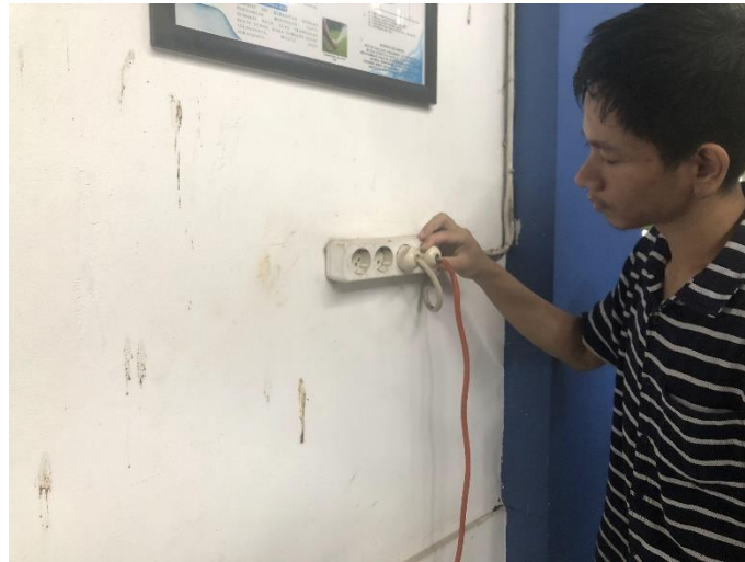
Gambar 21. Menghidupkan pompa air.
