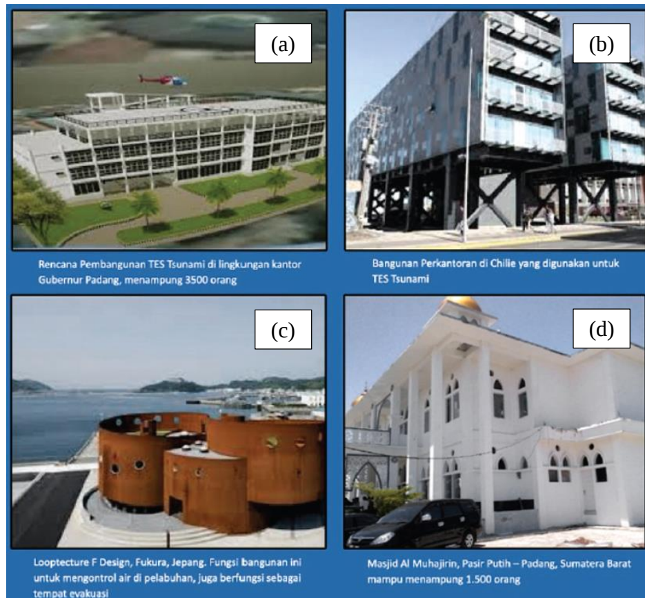
Gambar 10. Contoh bangunan umum TES, (a) TES kantor Gubernur Padang, (b) TES perkantoran Chillie, (c) TES Looptecture F Design Fukura Jepang, dan (d) TES Masjid Pasir Putih Padang. (Sumber : BNPB, 2012).
