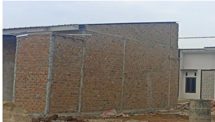
Gambar 13 Nampak Rumah Subsidi dari Sisi Samping Sumber Gambar : Rumah Subsidi Rajabasa Regency
