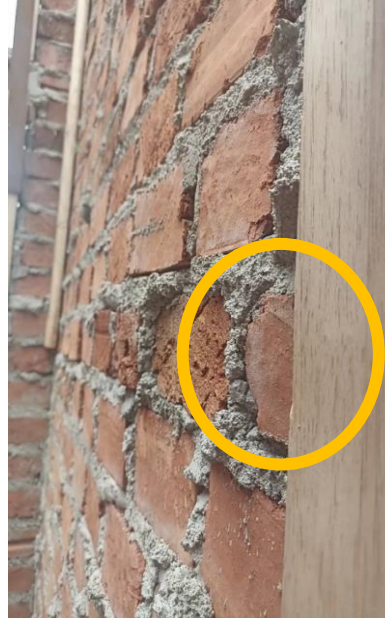
Gambar 9 : Foto Dinding Susunan Bata dari Sisi dalam Terdapat Sambungan Bata Silang Bersiku
