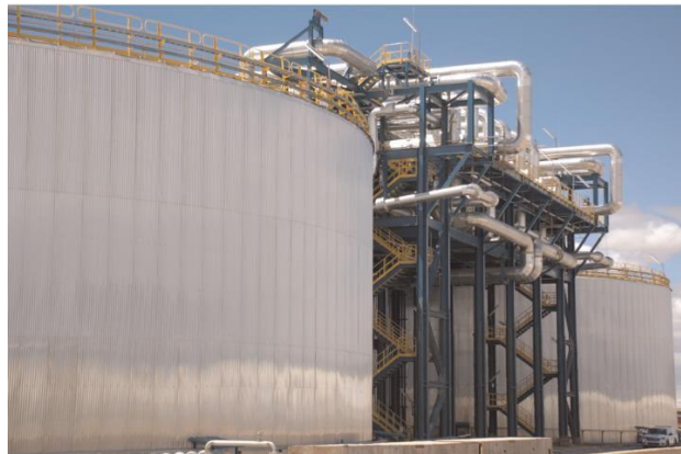
Gambar 2.1 Contoh 1000 MWh th sistem penyimpanan garam cair dua tangki dari pembangkit listrik tenaga surya terkonsentrasi di Spanyol (Bauer et al., 2021)
