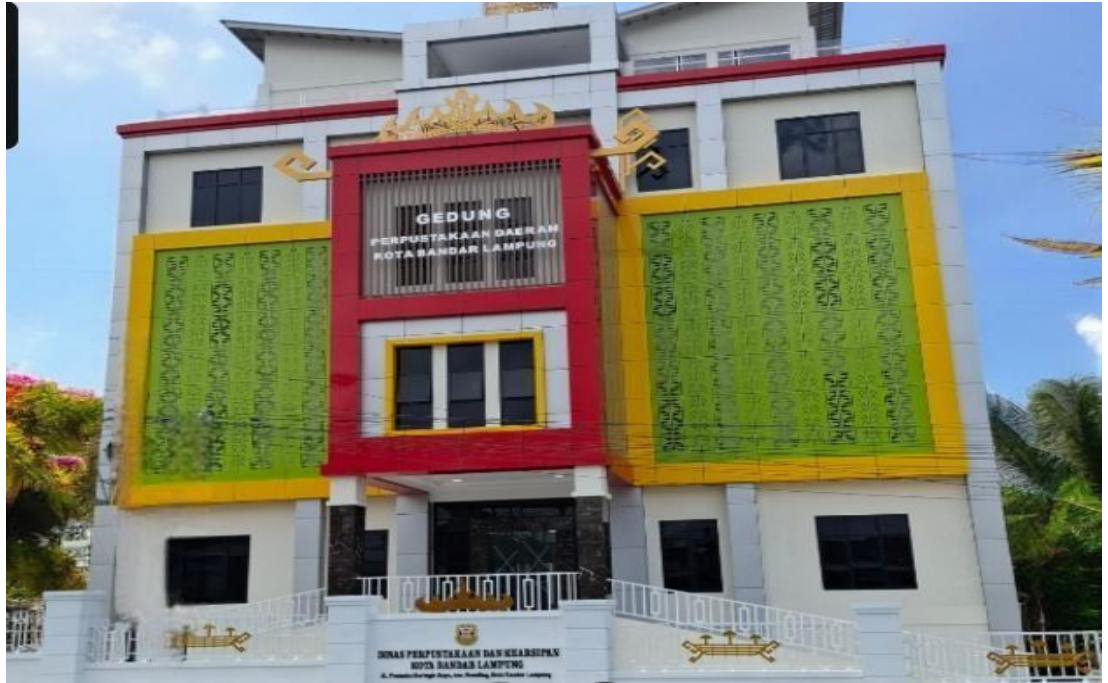
Gambar 1. Gedung Perpustakaan Daerah Kota Bandar Lampung
