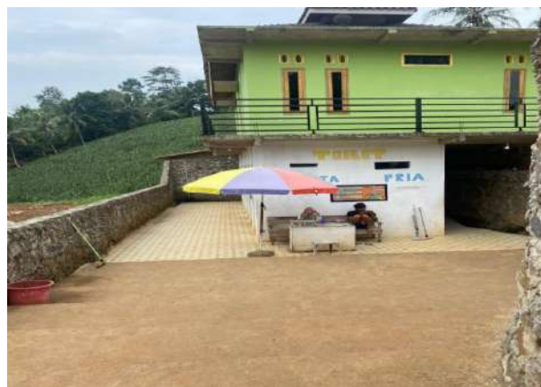
Gambar 7. Toilet di Way Tebing Ceppa
