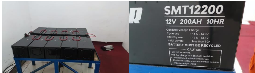
Gambar 2.20 Kapasitas Baterai di PLTG
